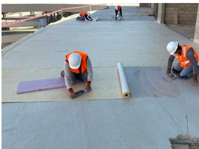
Impermeabilización de 35.000 m 2 de DRY120 en todas sus cubiertas transitables exteriores. CENTRO COMERCIAL PENÍNSULA. Tijuana. Mexico.
