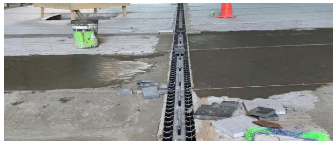
Impermeabilización de 18.000 m 2 con DRY120 y canalización con WALK LEVEL . PROYECTO RESIDENCIAL Y COMERCIAL URBANA CENTER APOQUINDO. Santiago de Chile.
