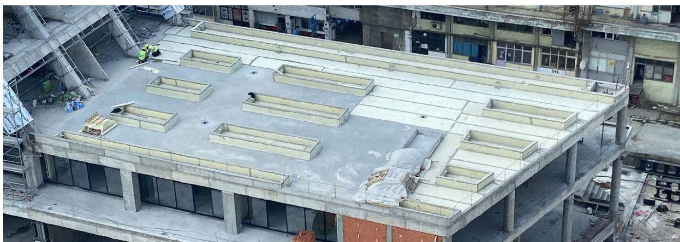
Impermeabilización de 20.000 m 2 de DRY120 en todas sus cubiertas transitables exteriores. ISTMAIL ESTAMBUL. Edificio para oficinas, universidad y centro comercial. Estambul. Turquía.
