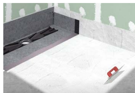
16. Recubrir el suelo de la ducha con cemento cola C2 S1/S2 y adherir la lámina ECODRY50 incluida en el kit.
