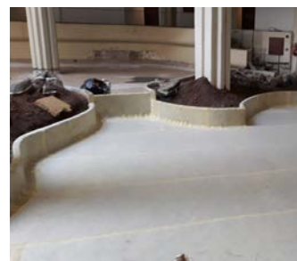
Impermeabilización de los jardines interiores con DRY80 diseñados por César Manrique. Hotel MELIÀ SALINAS Costa Teguise. Tenerife.
