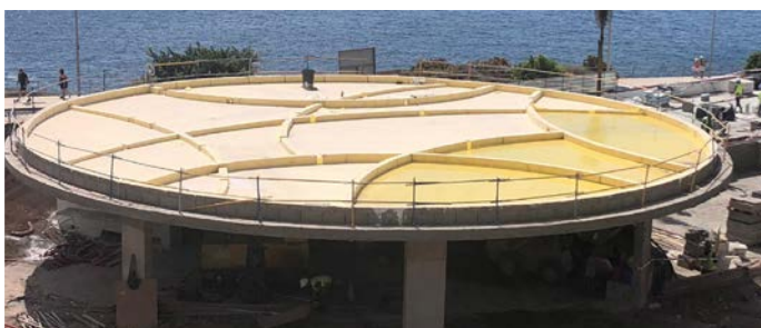
Impermeabilización con DRY80 de la cubierta del bar piscina del resort de 5 estrellas de la CADENA H10_Costa Adeje (Tenerife).
