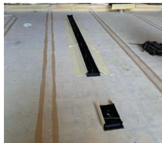
Impermeabilización de 18.000 m 2 con DRY120 y canalización con WALK LEVEL . PROYECTO RESIDENCIAL Y COMERCIAL URBANA CENTER APOQUINDO. Santiago de Chile.
